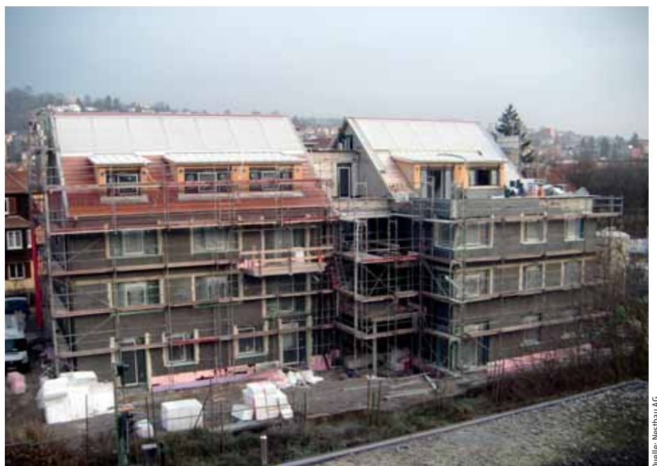
Das Tübinger Projekt der Nestbau AG während der Bauzeit, oben rechts kurz nach seiner Fertigstellung
